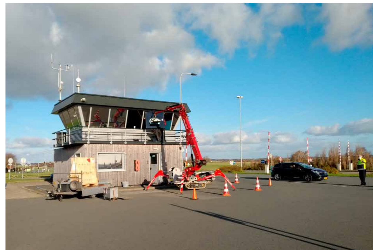
November 2020: plaatsing van innovatieve verduisterbare beglazing in de verkeerstoren op Texel.
