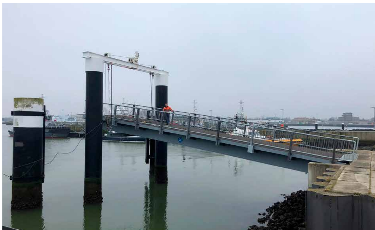
Augustus 2020: de noodaanlanding is semipermanent voorzien van een eigen brugdeel, in geval van een calamiteit kan nu vrijwel direct naar de noodaanlanding worden uitgeweken.
