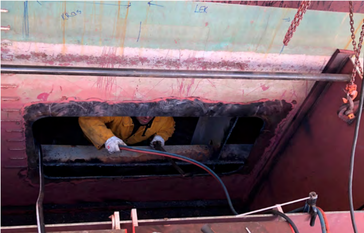
Februari 2022: reparatie van de romp van ms. 'Texelstroom'.
